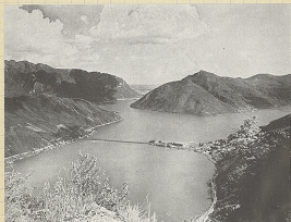
Der Damm bei Melide
