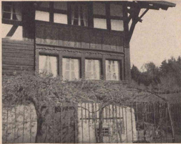
Abbildung 1 «Vordere Rüti» Wädenswil, aufgezogene Falläden
