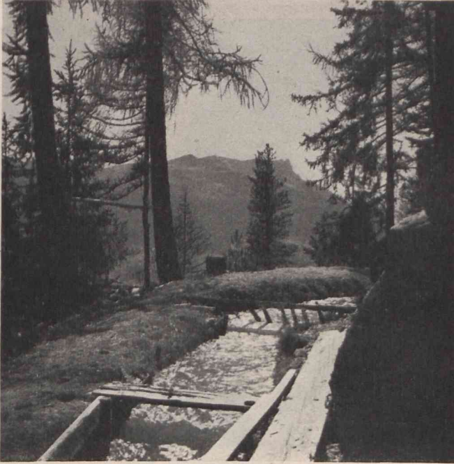
Die Wasserleitung von Saxon
