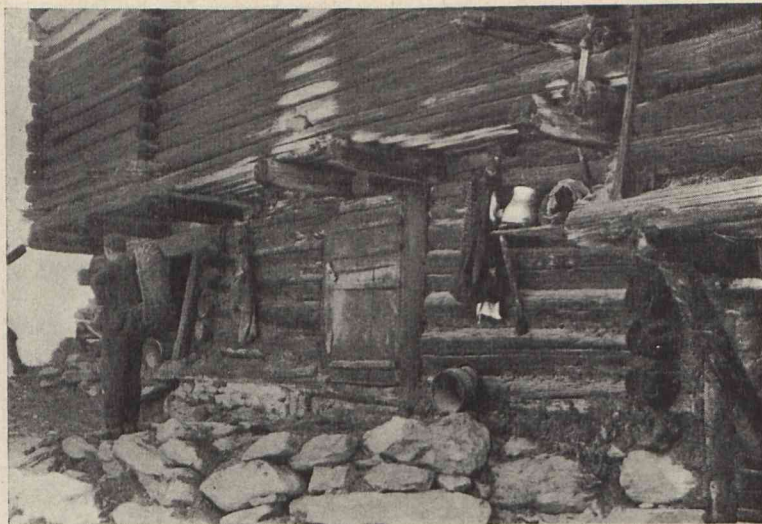
Stallvorhof eines alten Vieh- und Heustalls — Cuort nuegl. Stallfront in Cumbels (Lugnez).
