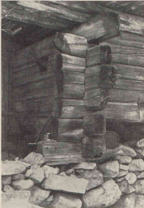
Tiefeingeschnittene Wettkopfreihe am Unterbau eines Stalls, «gestriekt, gedübelt und bemoost». Links oben vorragender «Oberschutz».
