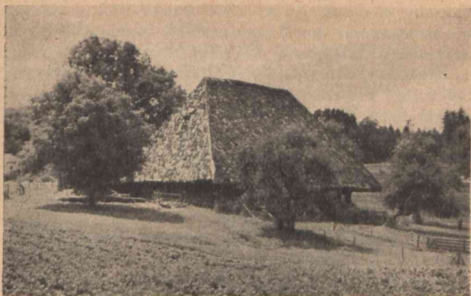
Berner Haus in ältester Form (Hegi, Bettenhausen, 1623). Dieses Dachhaus, ein Hochstudhaus, früher mit Stroh gedeckt, ist der Vorfahre der neuen Berner Häuser. Es ist noch anzutreffen im bernischen Oberaargau, im Aargau und im Seeland.
