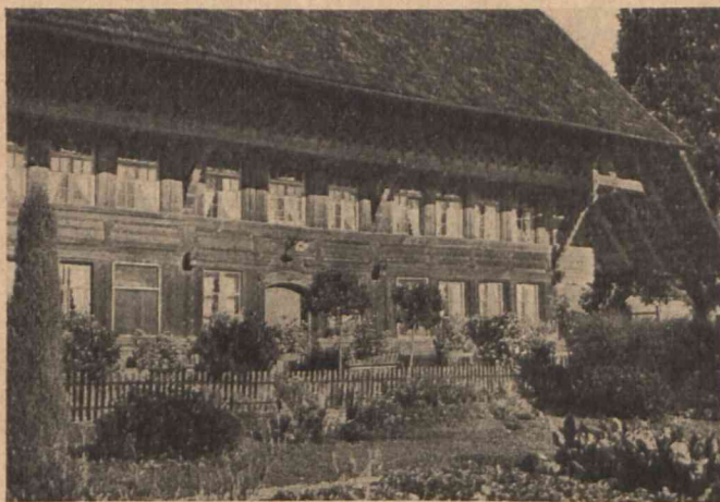
Das Gesicht des Hofes Oberfürten (s. Schulwandbild) mit seiner freundlichen Fensterfront, seiner schönen Bühnislaupe und dem verzierten Balkenwerk unter dem breiten Vordach.
