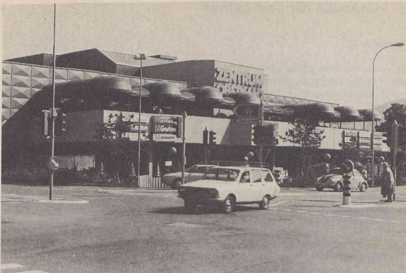
Abb. 11: Eingang zum MMM-Zentrum Oberland.
