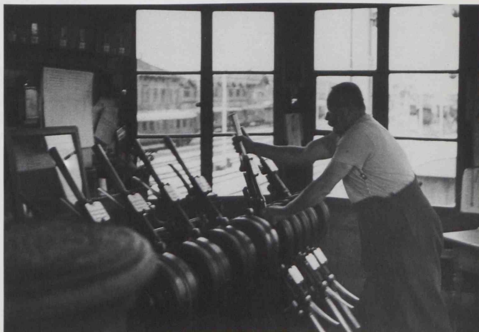
Abb. 4 Weichenstellung mit Kraft von Hand um 1930. Noch existierte keine elektronische Fernsteuerung.
