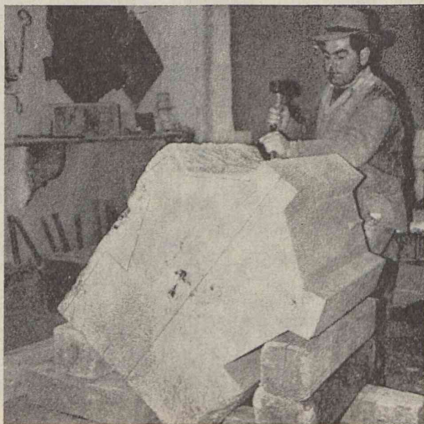
Restaurations- arbeiten an einem gotischen Münster
