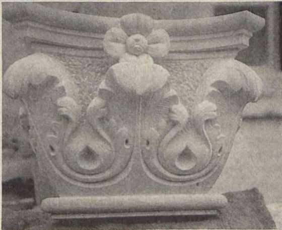
Restaurationen am Kloster Einsiedeln Lisenenkapitell – Nachformung in Schmerikon Sandstein
